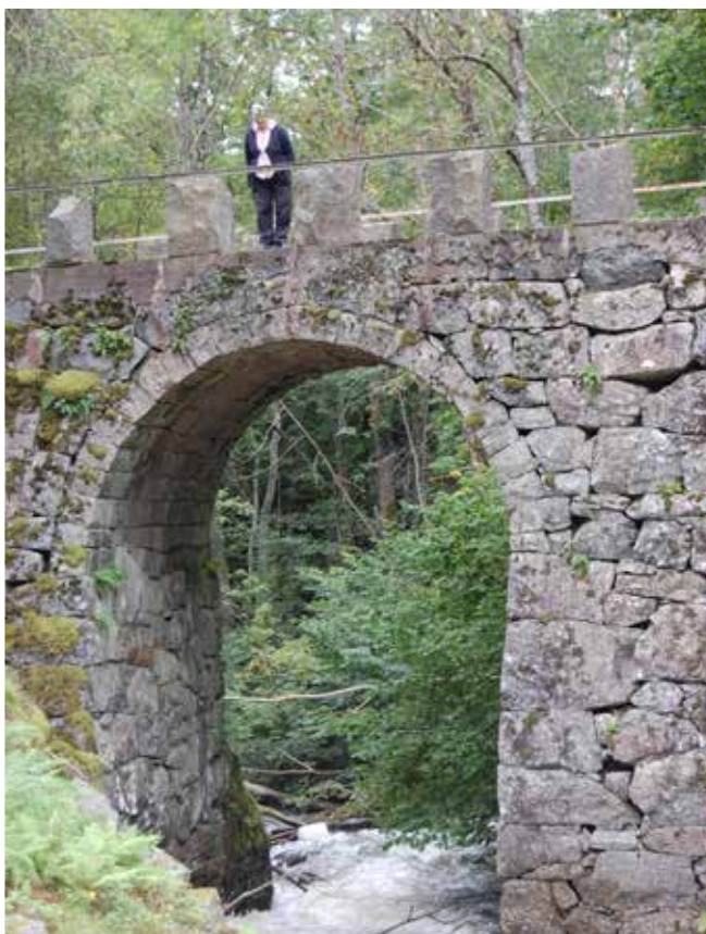
2_Glenne bro er oppført av hoggen granitt og har en noe spesiell hvelvet form_DSC_1347.JPG
