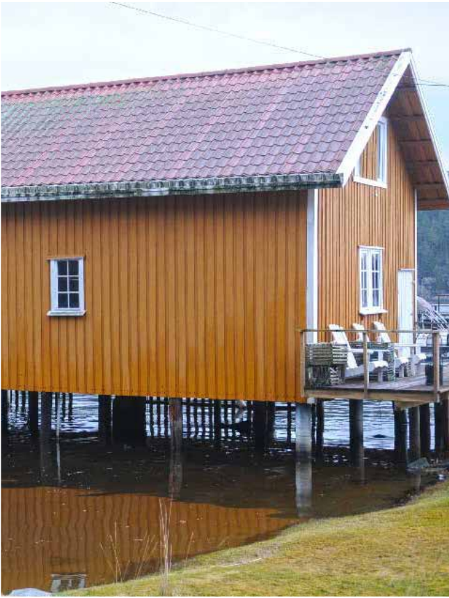
10_Sjøbod-i-Bukta-som-er-bevart-fra-den-rike-sildeperioden_Foto-Svein-Norheim_-DSC_0722.jpg sysselsatt opp mot 120 personer
