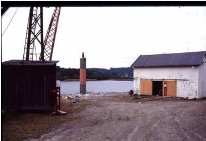
1_Fagerholt med saghuset monumentet som er en granittsøyle egentlig laget til papirindustrien_Til venstre ses krana_Foto-Lars-Erik Hammar_1158.jpg
