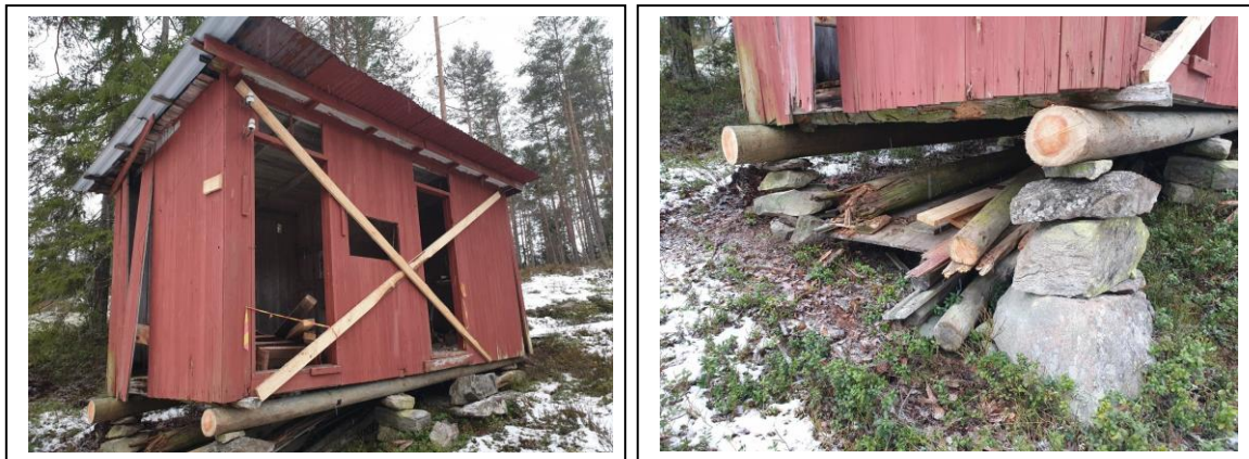
Rävlyckan, Rävmarken: Skjutbanehuset. Oppretting av utglidninger. Nye underliggere og stenfundamenter. Foto: Conny Olsson.
