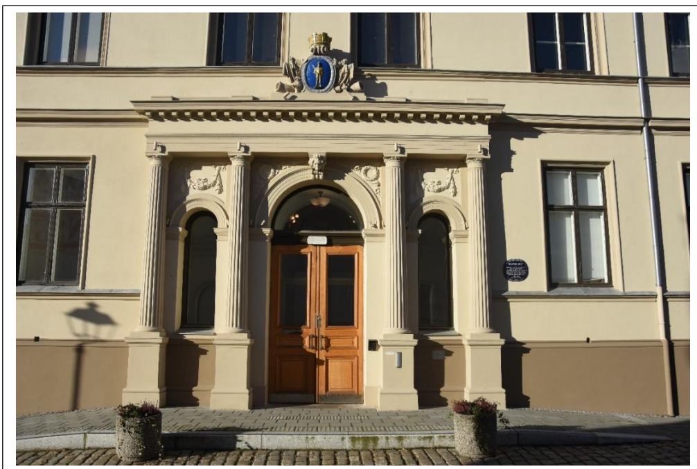
Rådhusets inngangsparti. Foto: Svein Norheim.
