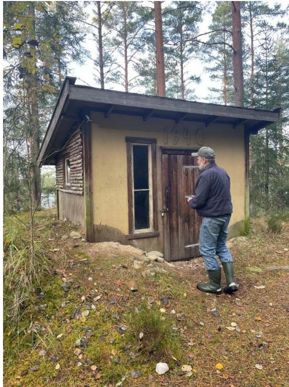
16. oktober 2024 var det befaring til Hjerténs vaktstuga ved den gamle veien mellom Berby og Krokstrand. Bo-Inge Hjertén bygde opp vaktstugan fra beredskapstiden/andre verdenskrig der faren hans hadde tjenestegjort. Ekomuseum Gränsland har fått henvendelse fra Strömstads kommun om dette er noe vi bør engasjere oss i. Hans -Inge Sältenberg vurdere bygningen. Foto: Svein Norheim.
