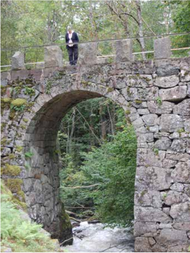
2_Glenne bro er oppført av hoggen grannitt og har en noe spesiell hvelvet form_DSC_1347.JPG
